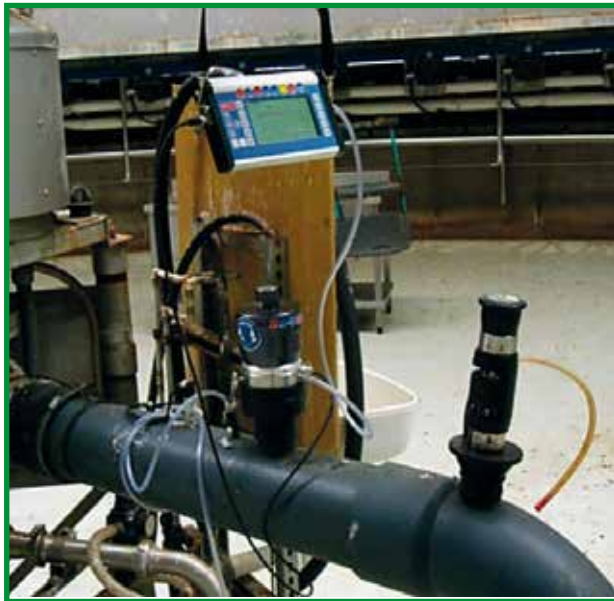
Abb. 4.2.1.: Vakuum- und Luftmessung im Melkkrusell
